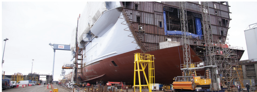
Un navire en chantier sur le site STX de Saint-Nazaire
