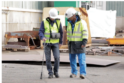
Analyse sur canalisations enterrées et aériennes
